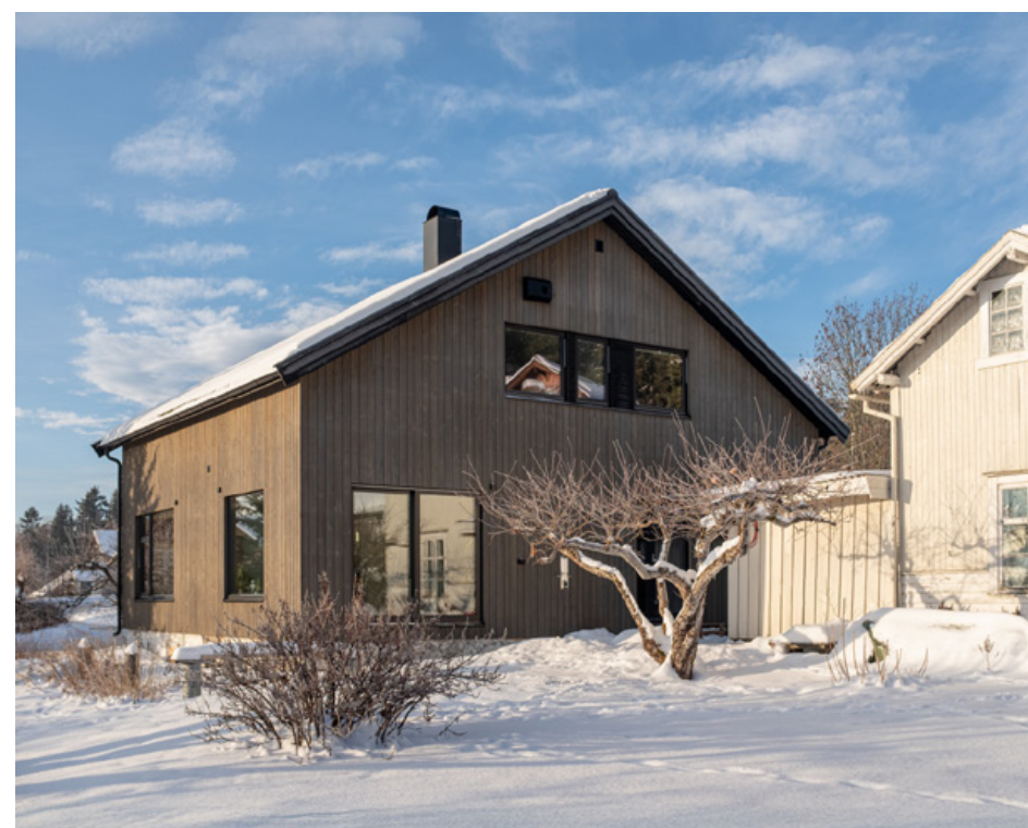
Totalrenovering av eget hus i Moelv
